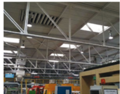
Bei Vetropack können in der Halle „Kaltes Ende“ Wartungsarbeiten an den Leuchten bei laufendem Betrieb vorgenommen werden.
